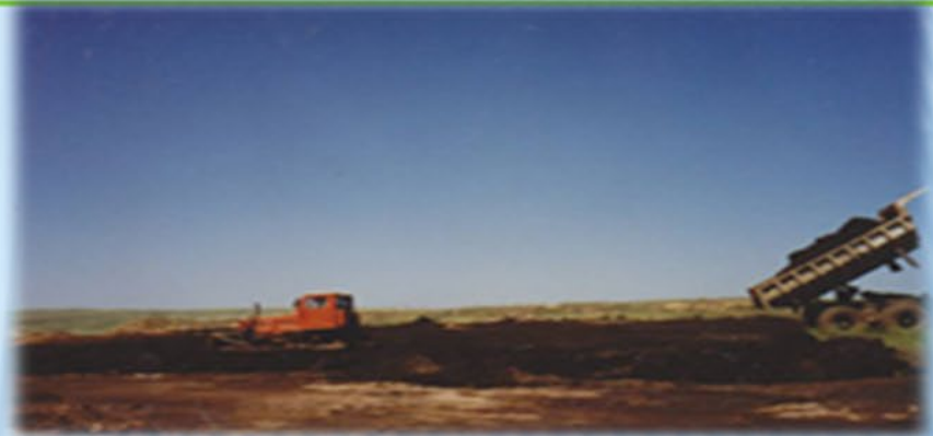
Формирование опытных участков на территории старого фенольного амбара ОАО «ОНОС»
